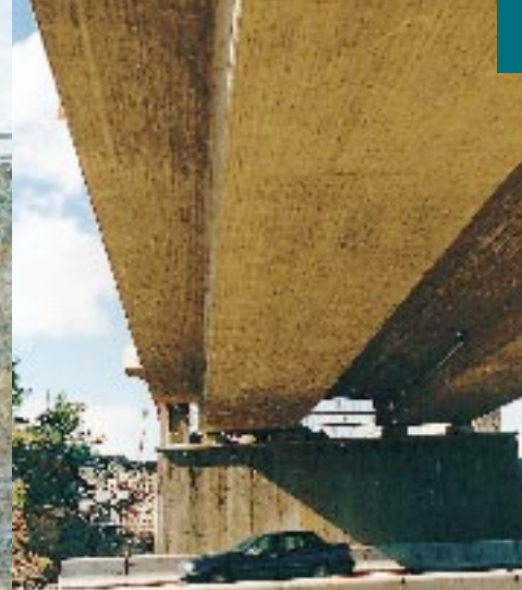
I anslutning till Arlandabanan byggs denna järnvägsbro över E4 norr om Arlanda.
