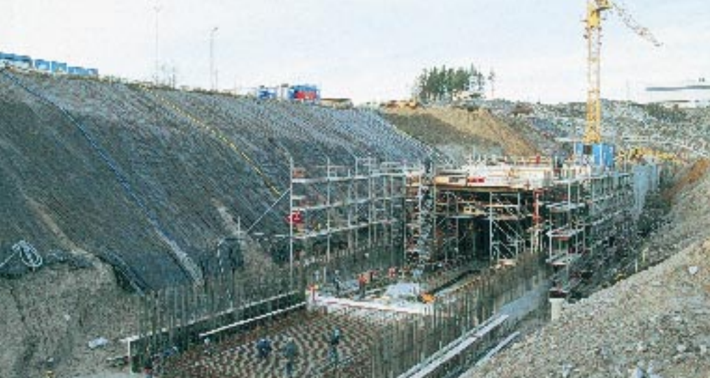
I februari 1997 nåddes en milstolpe i byggandet av Arlandabanan, då den norra och södra tunneln möttes under Sky City på Arlanda flygplats.
