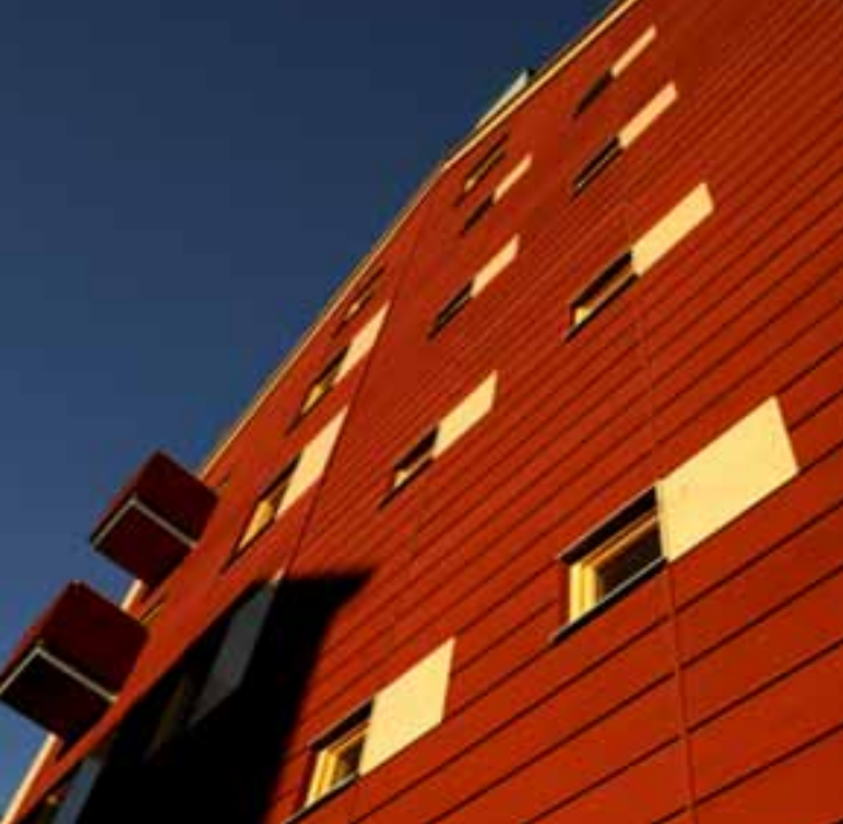
I Inre hamnen i Sundsvall uppför NCC det största trähusbygget av bostäder hittills i Sverige. De fem femvåningshusen med sammanlagt 94 lägenheter har en unik konstruktion med stommar i massivt trä och helt träklädda fasader.
