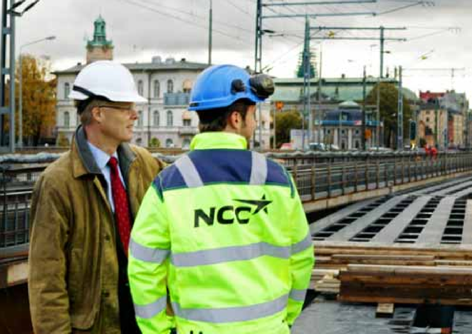
Alf Göransson besöker arbetsplatsen vid Tegelbacken i Stockholm där NCC bygger om signalsystem, växlar och spår samt breddar bron med mera. På bilden samtalar han med Johan Rudheden, praktikant inom NCC Construction Sweden, Anläggning Stockholm/Mälardalen.
