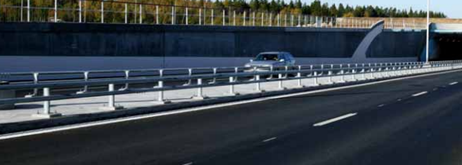
Riksväg 26 vid Skultorp i Skaraborg. NCC Roads uppdrag omfattade asfaltbeläggning av en av etapperna i projektet.
