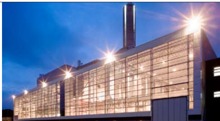
Rya kraftvärmeverk, Göteborg.
