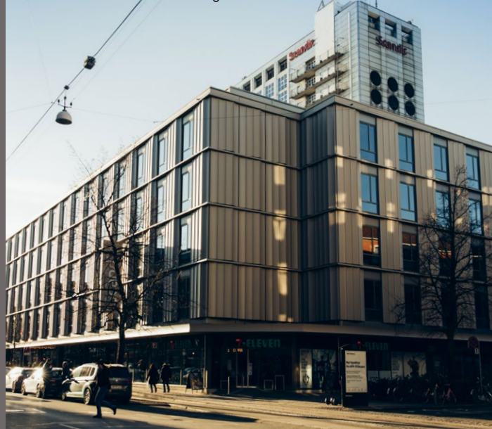
Falkoner Centret efter renovering.
