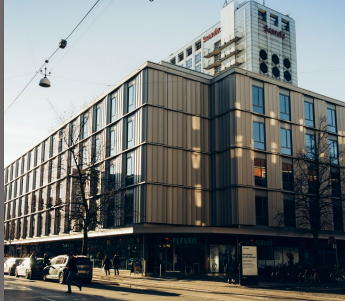
Falkoner Centret efter renovering.
