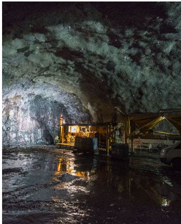
Andra tunneln på Färöarna – Sandøytunneln
