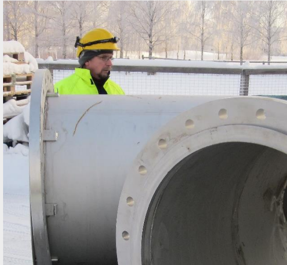
Anläggning i Finland
